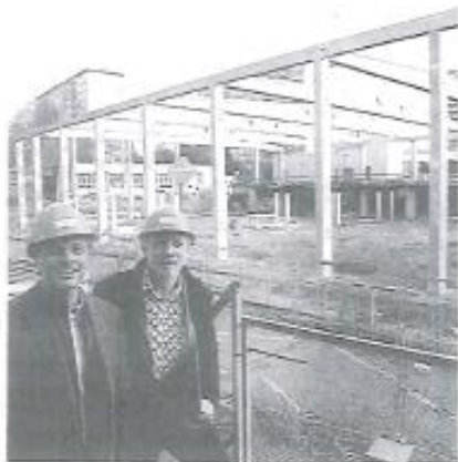
M "Depuis une semaine, les voûtes des salles ont été installées", expliquent les édiles. © SALVENDY
